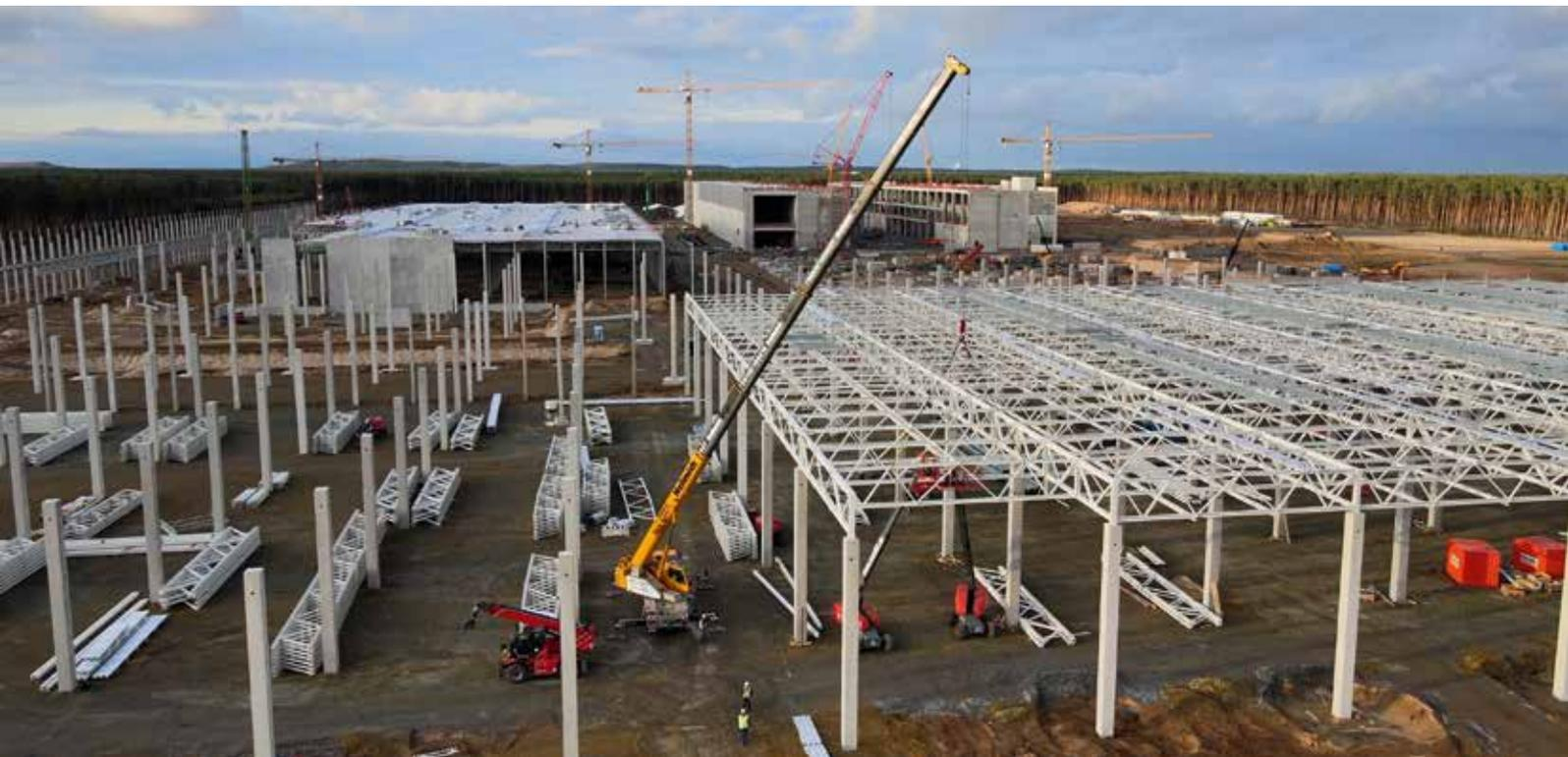
Just-in-time-Montage: mit mehreren Kranen wird gleichzeitig Stützen, Binder und Dachverbindungen montiert
