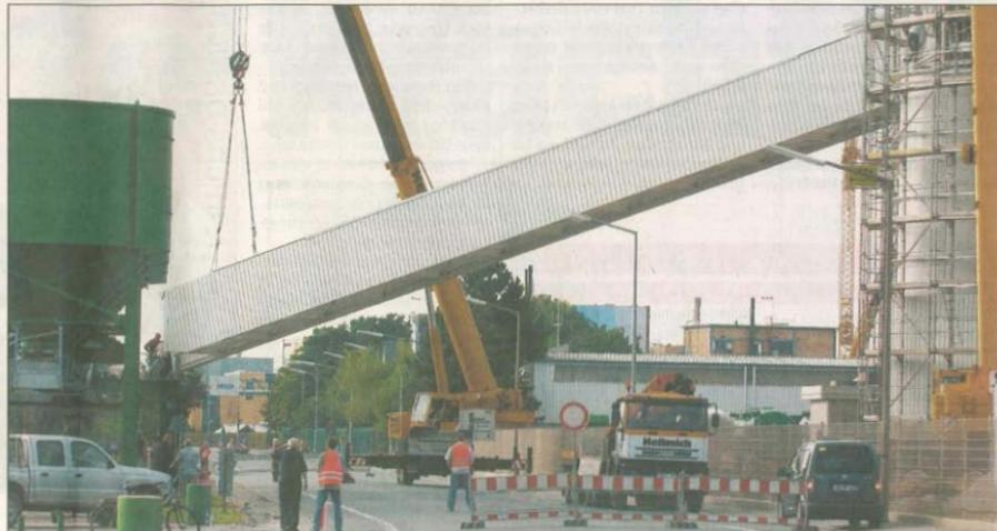
Passgenau wird die neue Förderbandbrücke der Firma Waibel über der alten B 44 eingesetzt.
